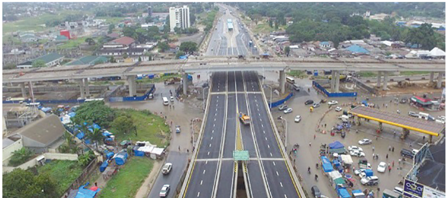
Muonekano wa maendeleo ya ujenzi wa barabara za juu Ubungo jijini Dar es Salaam. (Ubungo Interchange).
